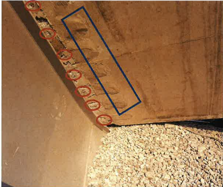
Figura IV.1.7 – Detalle de los pernos Nelson
