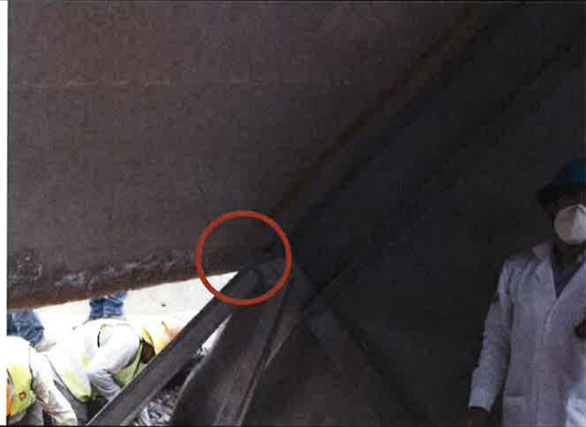
Vista general del contraventeo (CV1) – trabe T-7
