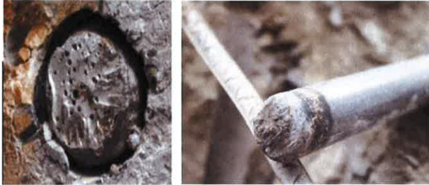
Figura IV.1.8 – Detalle de los pernos Nelson
