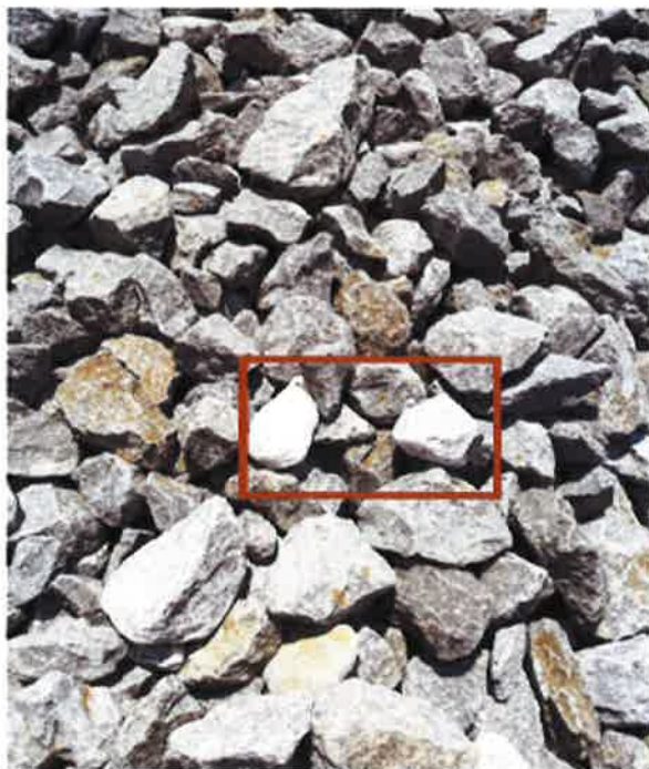
Figura IV.1.25 - Detalle de Balasto
