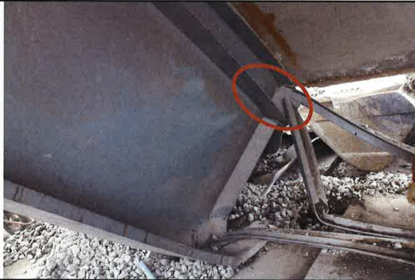
Vista general de trabe T-1 – contraventeo CV-1
