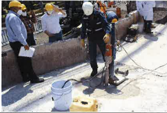
Instalación del equipo extractor de núcleos
