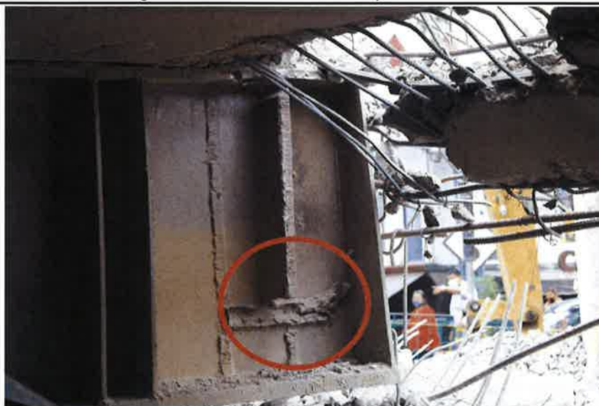
Figura IV.1.3- Conexión trabe T-3-trabe puente- trabe T-6
